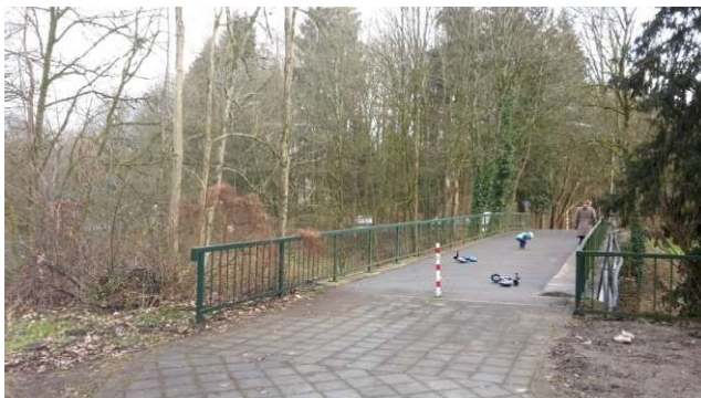
F2: Aggerbrücke Werthsiefen, Position 8
